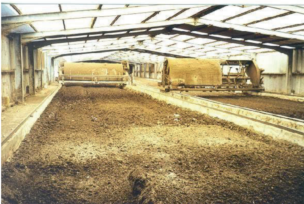
Σχήμα 5. Εικόνα μηχανικά αναστρεφόμενων κομποστοσωρών στερεών αποβλήτων πτηνοτροφείου αυγοπαραγωγής.
