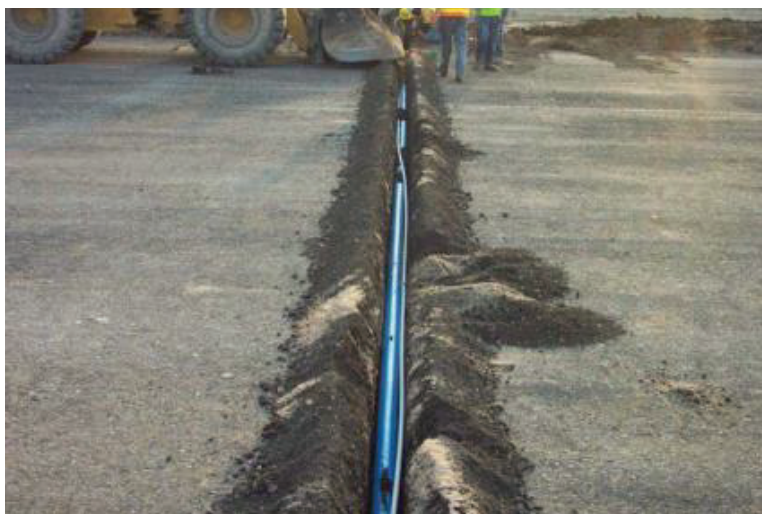
Εικόνα 1 - Εγκατάσταση οριζοντίου κλισιομέτρου για την παρακολούθηση της καθίζησης επιχώματος (Πηγή: Βιβλιογραφία [5])
